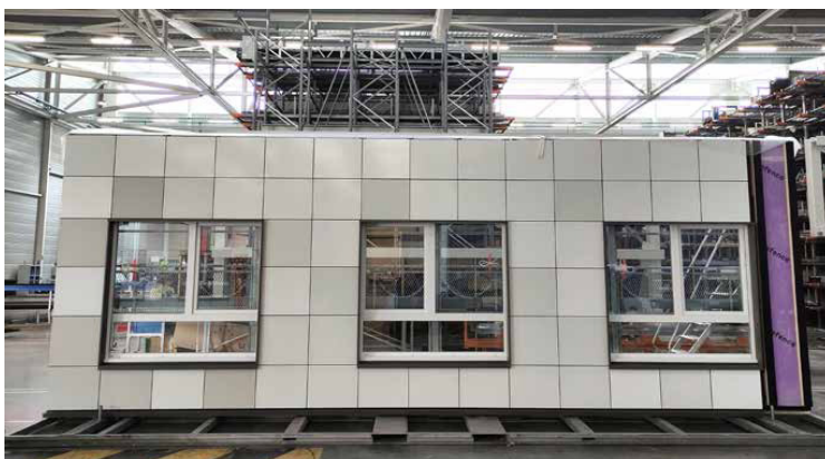
Les façades ossature bois des résidences Sciences et Lettres ont été préfabriquées en usine. Ces panneaux intègrent l'isolation thermique, les menuiseries et les finitions extérieures. ©SYbois
